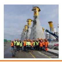
(\*) les fondations s'échelonnent en réalité entre 48 et 54 mètres de hauteur totale afin de compenser la profondeur des fonds marins et faire apparaître une hauteur émergée moyenne identique pour des raisons esthétiques. Le projet mentionne une moyenne de 30 mètres immergés ; en réalité cette immersion s'étalera entre 25 et 40 mètres pour les raisons évoquées plus haut.
